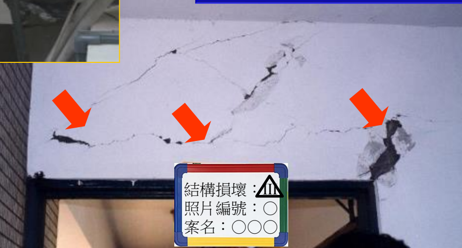
梁端斜裂縫，保護層剝落
