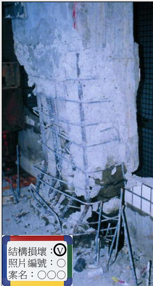
柱底混凝土爆裂，鋼筋挫曲
