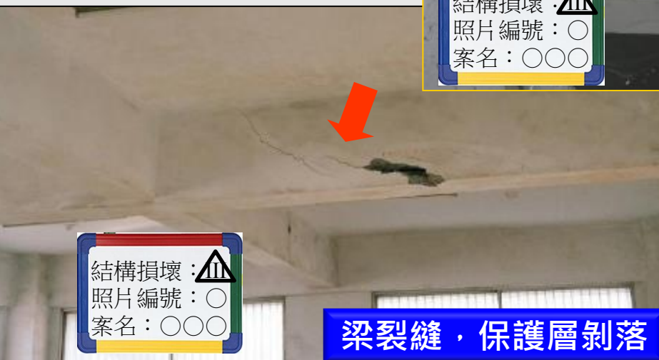
梁裂縫，保護層剝落
