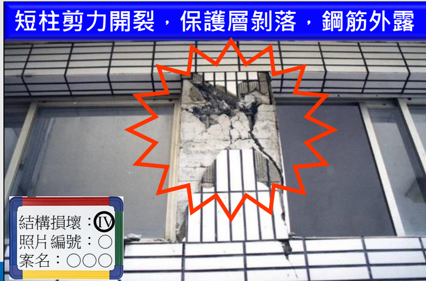
結構損壞：IV 照片編號：○ 案名：○○○
