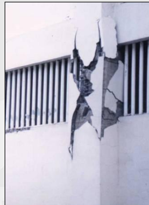
高窗短柱剪力破壞(V)
