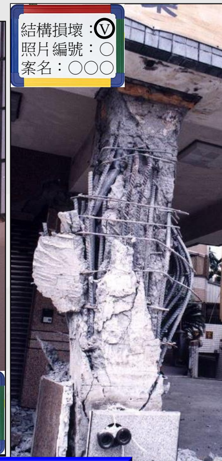
柱混凝土爆裂，鋼筋挫曲
