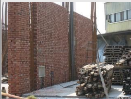
砌磚後綁鋼筋
