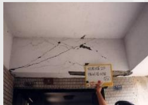
短梁剪力破壞實例
