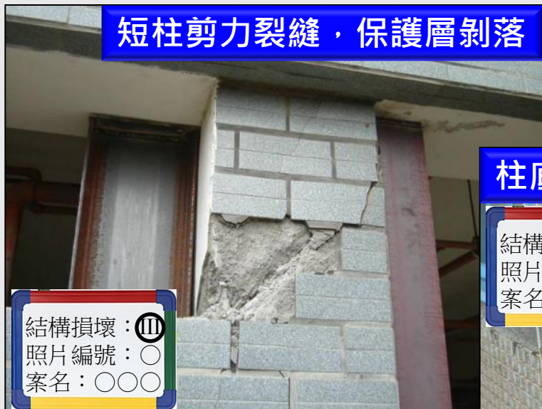
柱頂開裂，混凝土剝落
