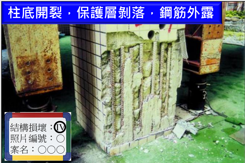
短柱剪力開裂，保護層剝落，鋼筋外露
