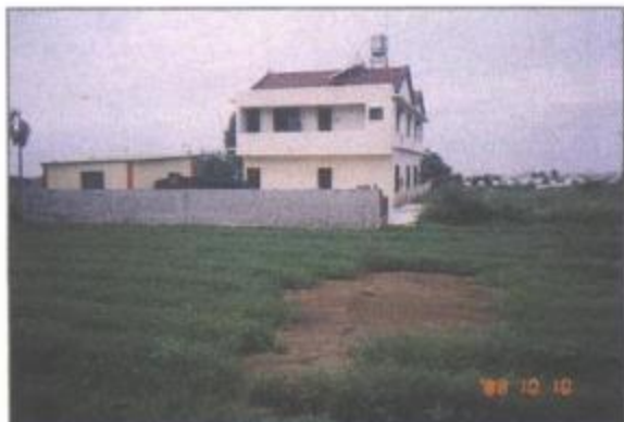
照片C-1-1 建物外側農地 地表大量噴砂
