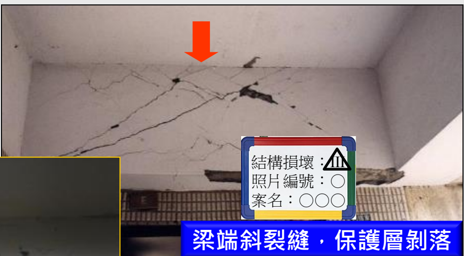
梁端斜裂縫，保護層剝落
