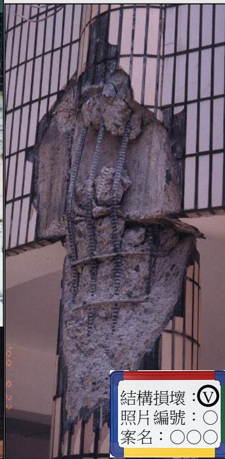
柱混凝土爆裂，鋼筋挫曲
