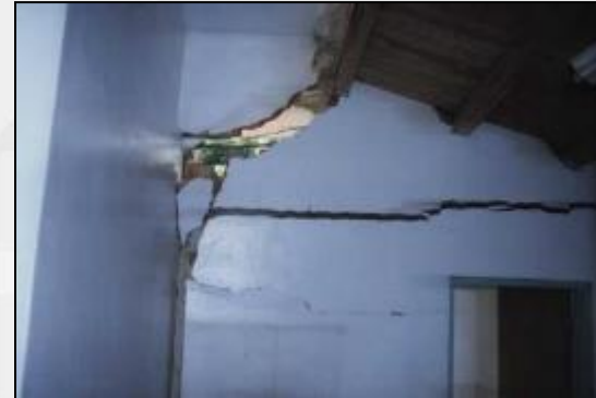
磚造牆斷裂
