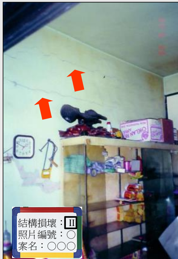
牆水平向裂縫
