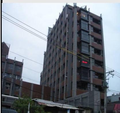
鋼筋混凝土造
