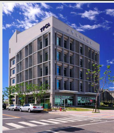
鋼筋混凝土造
