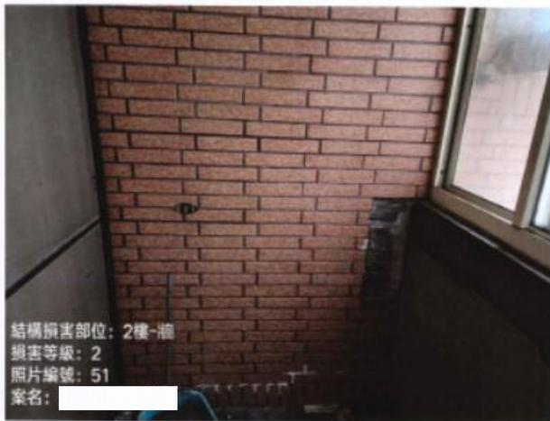
照片 51 : -2樓-牆[損壞等級:2] 牆長度:4.0M、牆損壞長度:0.3M
