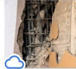
A棟-柱核心混凝土碎裂已喪失機能-01.jpg
