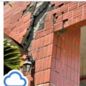
E棟~B棟-柱頭受造型牆擠壓損害-02.jpg
