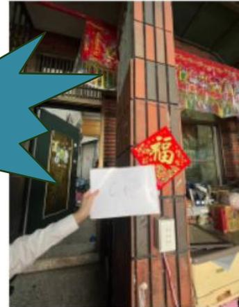
描述：C1柱：0級損壞(非支撐柱)
