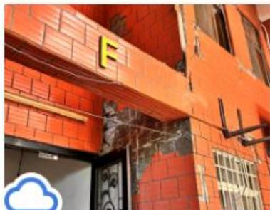
F棟-入口梁柱接頭損害-01.jpg
