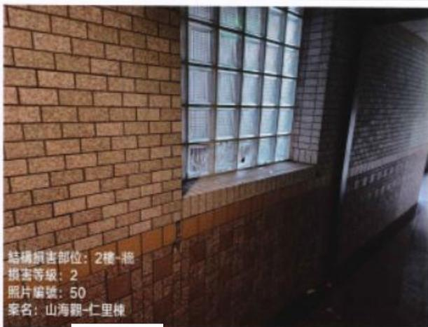
照片 50 : -2樓-牆[損壞等級:2] 牆長度:4.0M、牆損壞長度:0.3M
