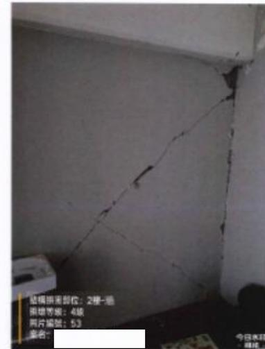
照片 53 : -2樓-牆[損壞等級:4] 牆長度:3.2M、牆損壞長度:3.2M
