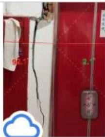
D棟-消防栓箱磚牆損害現況-01.JPG
