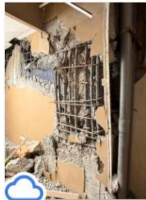
A棟-樓梯間柱損害嚴重鋼筋挫屈
