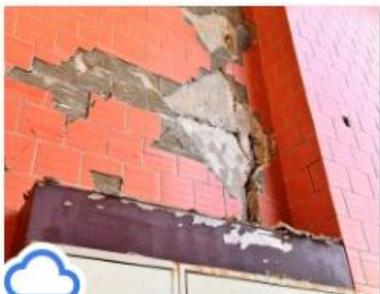
B棟-非結構RC牆損害現況-01.jpg
