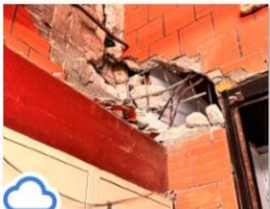
F棟-入口非結構RC牆損害-01.jpg
