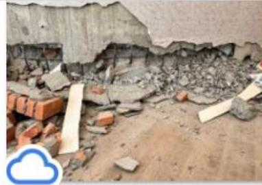
A棟-非結構RC牆損害現況-01.jpg
