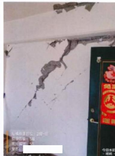
照片 55 : k-2樓-牆[損壞等級:5] 牆長度:3.2M、牆損壞長度:3.2M
