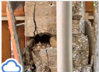
D棟-柱斷面損害現況-01.jpg
