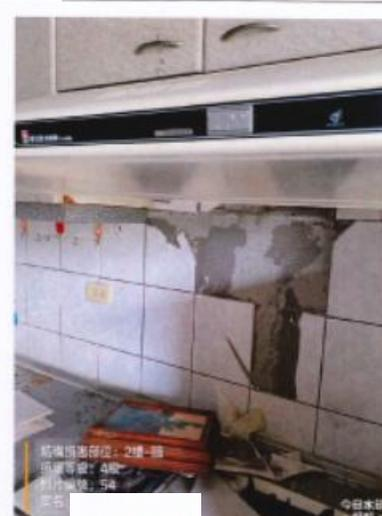
照片 54 : -2樓-牆[損壞等級:4] 牆長度:7.0M、牆損壞長度:3.0M
