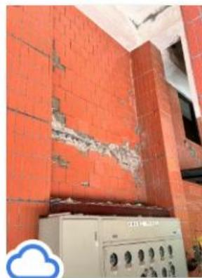
B棟-電錶箱非結構RC牆損害現況-01.jpg
