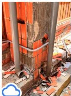
B棟-柱頭埋管柱斷面減損現況-01.jpg
