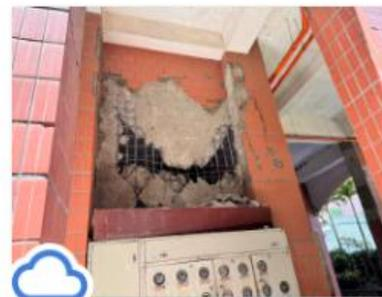
E棟-電表箱非結構RC牆損害嚴重-01.jpg
