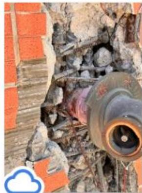
A棟-柱被消防栓管剪斷主筋現況-02.jpg
