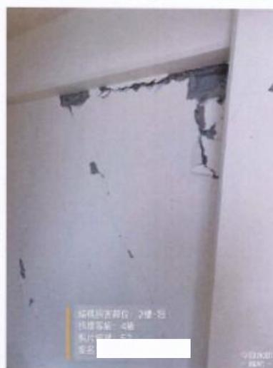
照片 52 : -2樓-牆[損壞等級:4] 牆長度:7.0M、牆損壞長度:4.2M
