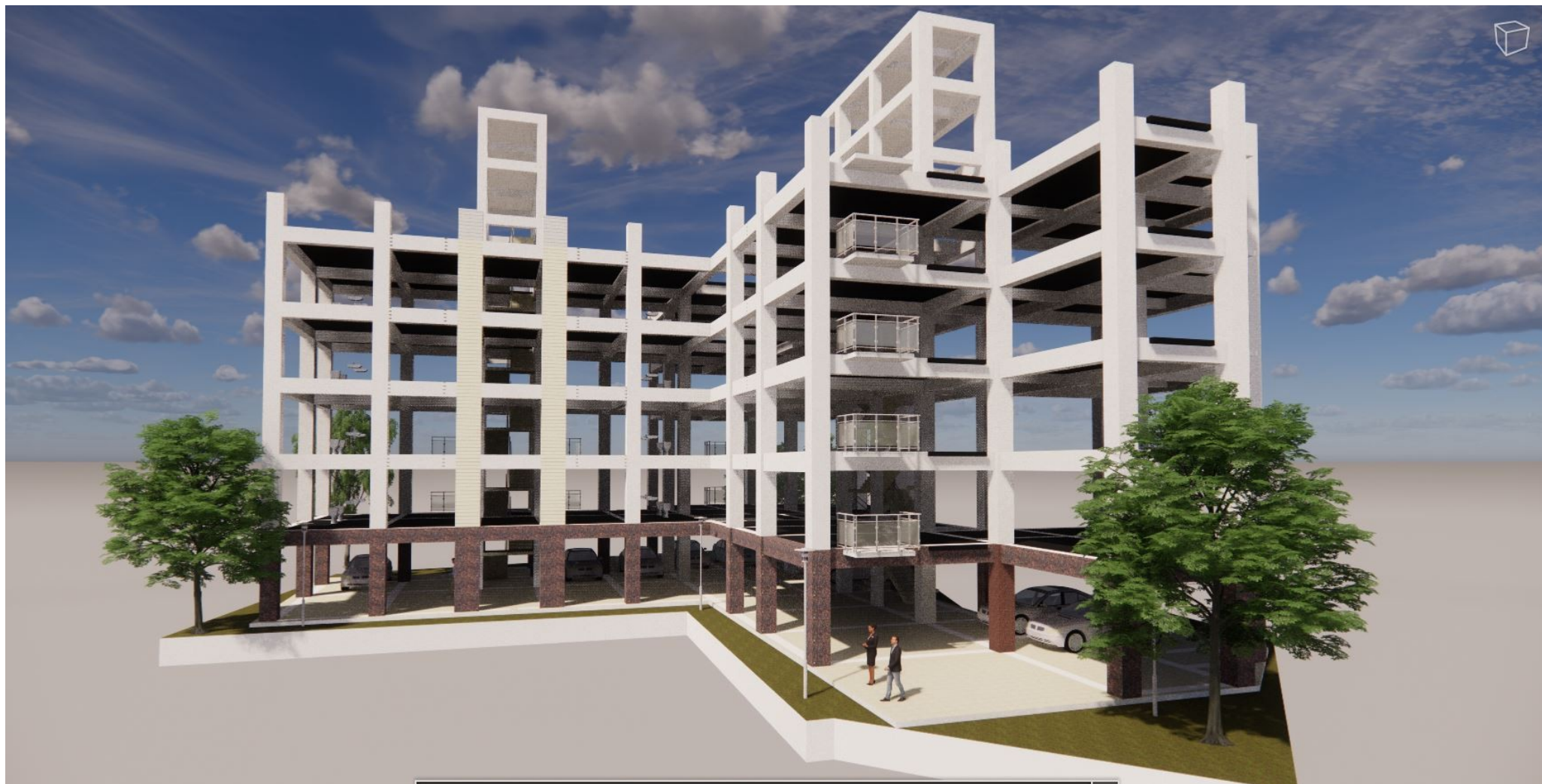
鋼筋混凝土結構外觀
