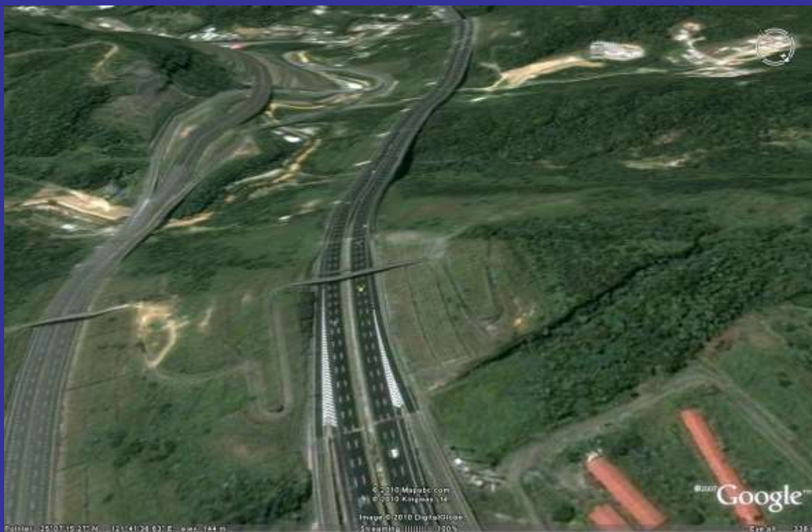
國道3號公路3.1K在2010年4月25日 崩坍前的照片
