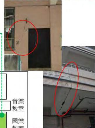
牆面剪力破壞，兩棟沿伸縮縫破壞
