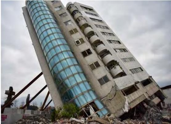
住商混合建築易有弱層產生，地震時容易發生崩塌
