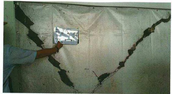
描述：P15：w1牆(四級破壞)有大量斜向裂縫可見牆內主筋
