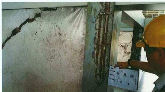
描述：P2：C2柱(四級破壞)保護層剝落,部份箍筋脫開
