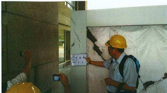
描述：P1：C1柱(二級破壞)明顯裂痕
